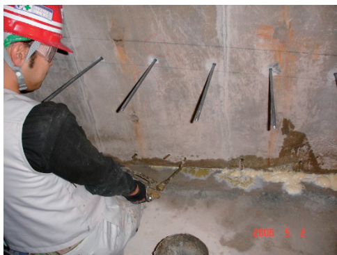
图1 某地下工程采用注浆法对渗水裂缝进行治理
