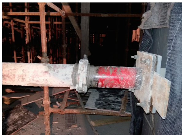
图2-2 泵管接管变径，与挡板不同心
