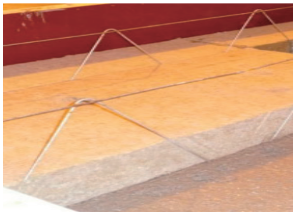
图20 安装后的连接件
