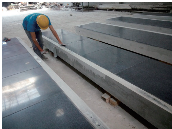
图25 光触媒涂炭防护
