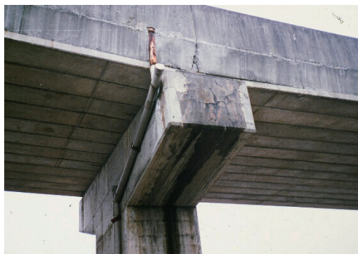
a. 桥墩端部因ASR网状开裂
