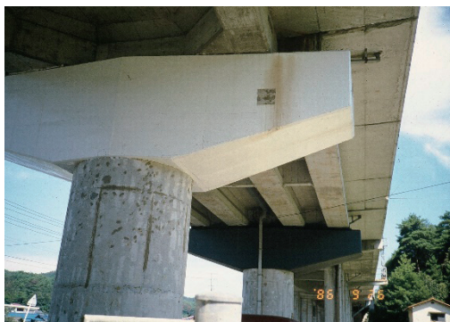
b. 裂缝封堵后涂装保护
