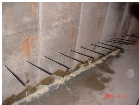
图1 某地下工程采用注浆法对渗水裂缝进行治理
