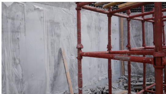
图6 混凝土墙体养护
