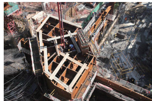
图7 MC2巨柱平面示意图与浇筑施工照片
