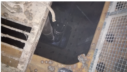
图5 内浇混凝土导管导入法浇筑
