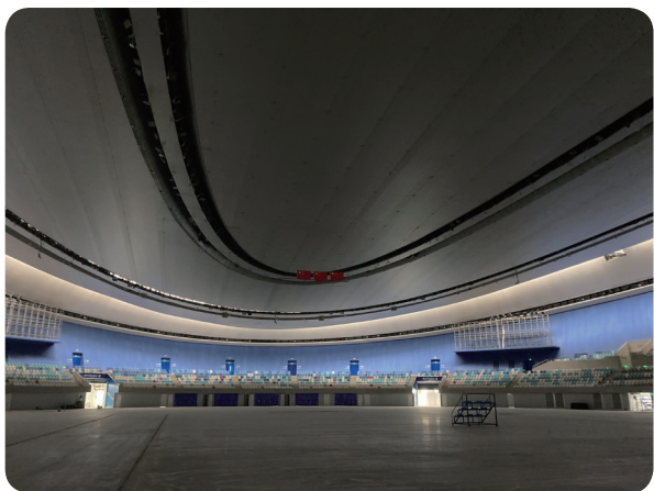
图9 国家速滑馆内部冰面承压层混凝土
