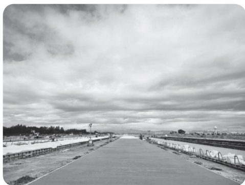
图2-3 图2-4 机场跑道道面混凝土局部施工浇筑、摊铺成型后的施工现场图
