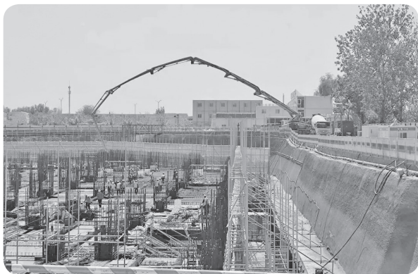
环球影城北交通枢纽浇筑现场
