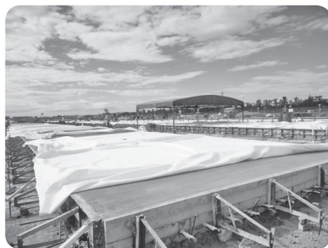
图2-3 图2-4 机场跑道道面混凝土局部施工浇筑、摊铺成型后的施工现场图
