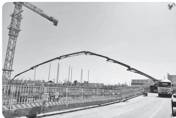
通马路综合交通枢纽浇筑现场
