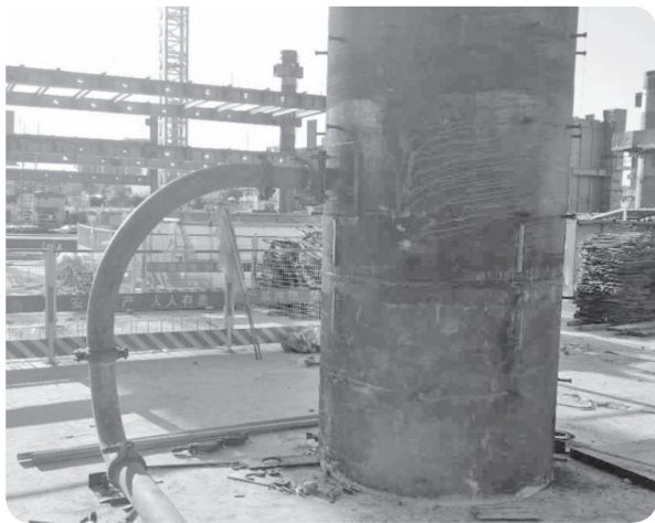
图例1 浇筑接口与钢管的连接
