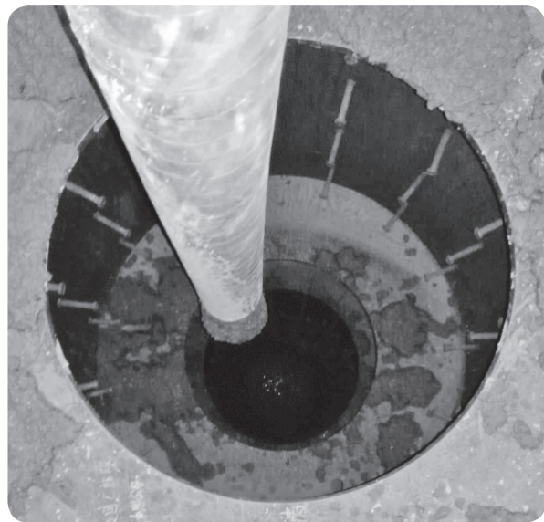
图例2 由泵送软管深入钢珠内降低自由倾落高度
