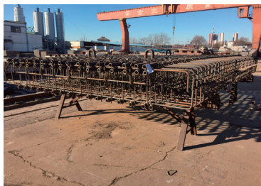
钢筋骨架绑扎
