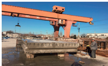
外墙混凝土粗糙面处理
