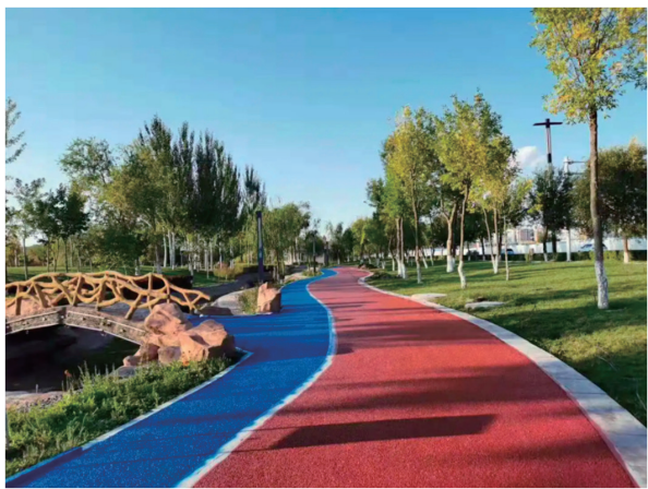
彩色透水混凝土应用实例
