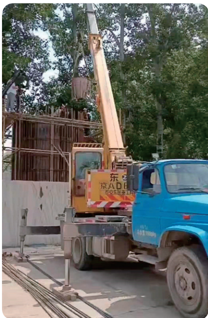
图4-8 吊车及吊斗现场作业
