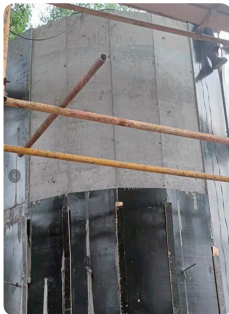
图4-9 拆除外模过程中的照片
