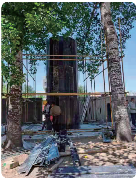
图4-3 圆柱体容器施工支模照片
