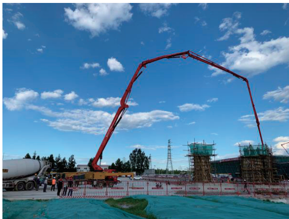
图5 一次性浇筑4m重晶石锯齿墙试验段
