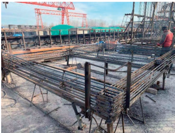
图7 钢筋半成品定位胎具
