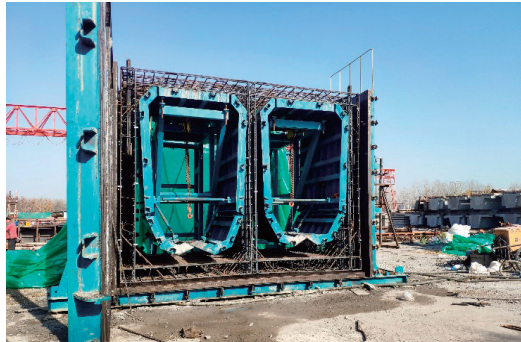
图10 钢筋入模图
