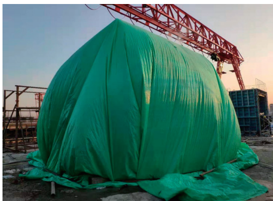
图15 蒸养示意图
