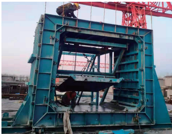
图13 混凝土收面图
