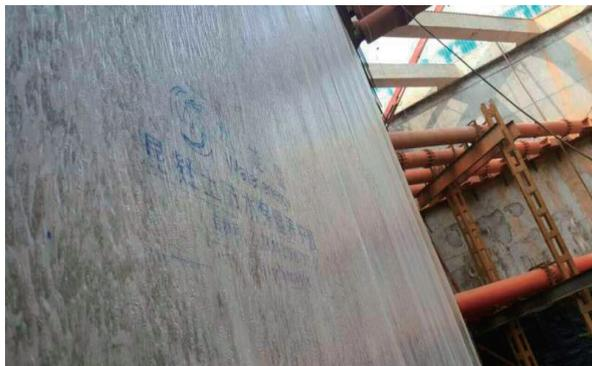
图1 混凝土节水保湿养护膜
