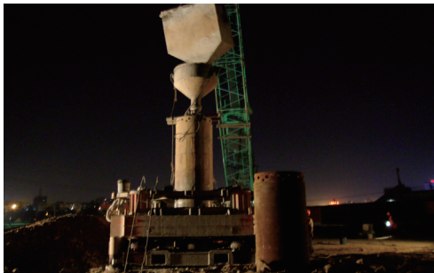
超保塑混凝土的浇筑
