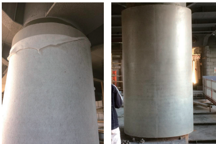
图5-1 清水混凝土养护
