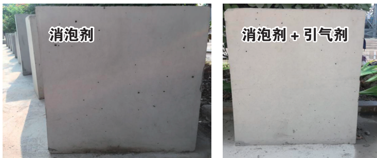
图4-2 消泡剂与引气剂对清水混凝土的影响
