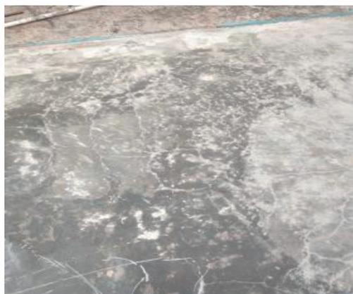
图2-3 严重裂缝情况
