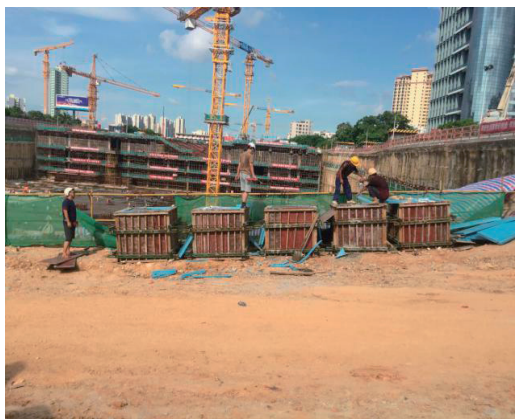
图 2.1 试验墩试验及保温效果图
