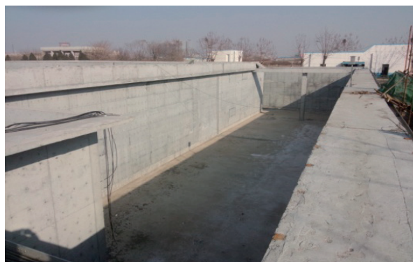
图1 浇筑完后局部墙体
