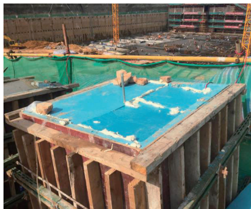
图 2.1 试验墩试验及保温效果图
