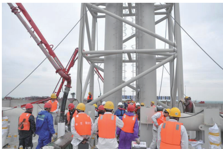
高流动性混凝土浇筑施工现场
