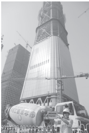
图2 建工新材助力中国尊混凝土浇筑
